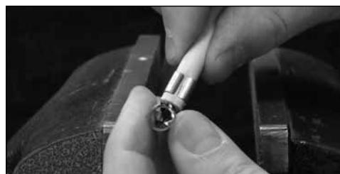
11. Para los terminales de puntos: deslice el capuchón sobre el terminal.
